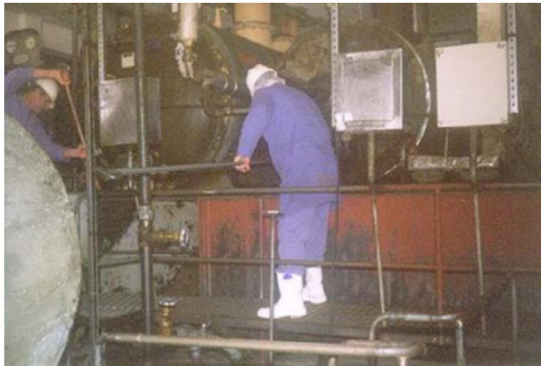
Figura 7 – Operação de desobstrução dos transportadores.
